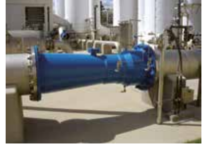
الشكلُ (33): مقياسُ فنتوري في إحدى محطاتِ المياهِ.
