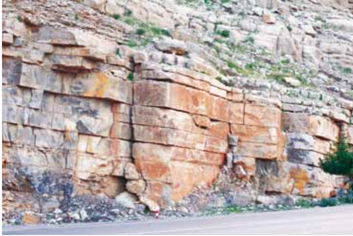
الشكل رقم (٣-١٢): الشقوق وأثرها في إضعاف الصخر.
