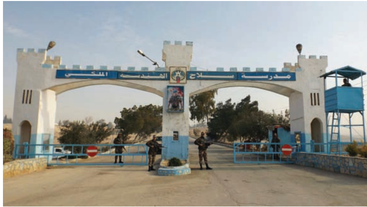
الشكل (٦-٩): مبنى مدرسة سلاح الهندسة الملكي.
