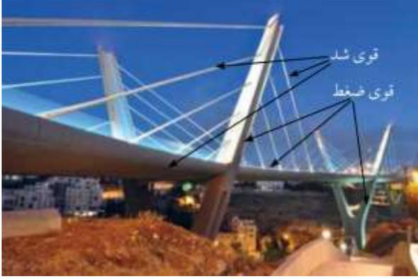
إذ يؤثر فيها قوى ضغط تجعلها تنكمش وتنقلص ، وقوى شد تجعلها تتمدد ويزداد طولها ؛ كما هو موضح في الشكل . لذا يجب أخذ هذه القوى في الحسبان عند تصميم أي جسر ؛ كي لا يتعرض الى التصدع والالتواء والانكماش ، لعدم تحملها ، وإيجاد وسائل وتصاميم مناسبة تعمل على توزيع هذه القوى على مختلف أجزاء الجسر بالشكل الذي يمنع تمركزها في منطقة واحدة .
