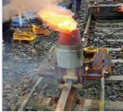
يستخدم تفاعل الشيرمايت في إصلاح السكك الحديدية حيث ينصهر الحديد الناتج بفعل الحرارة، ويصب مباشرة في أماكن الكسر في السكة الحديدية.
