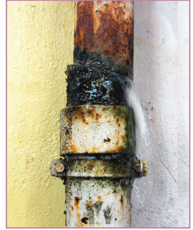
الشكل (20): طبقة من الصدأ المتكونة على أنبوب تصريف المياه العادمة.
